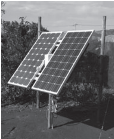
〈写真1〉製作したシステムの外観
