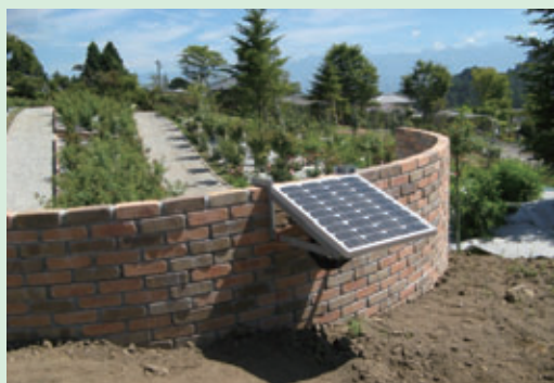
(a) 太陽電池モジュールの設置状況
