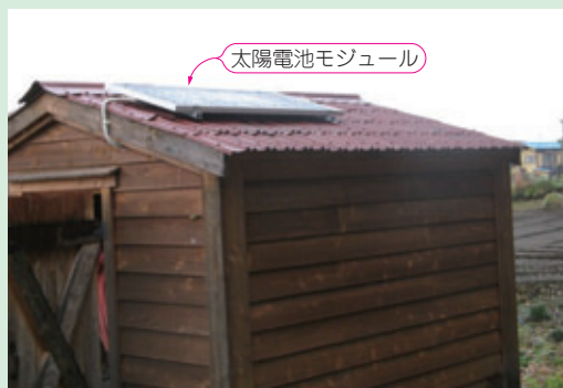
(a) 屋根の上に太陽電池モジュールを設置
