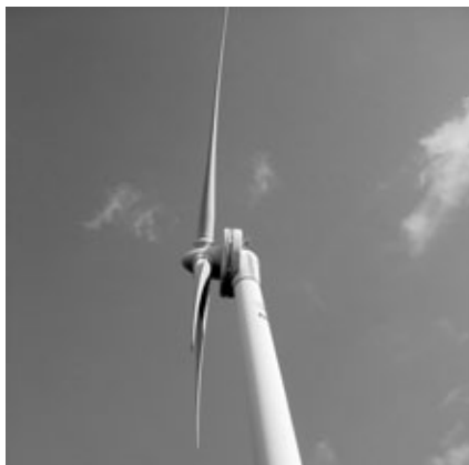
写真0-1 風力発電用の多極同期発電機 壱岐芦辺風力発電所，750kW，年間平均風速6.8m/s
