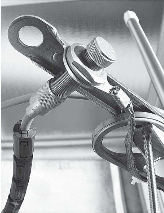
写真1-1-9 取付金具に中継コネクタと同軸ケーブル類をセット
