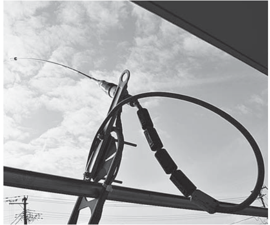
写真1-1-10 アンテナ設置完了
