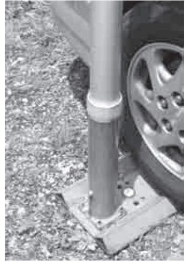
写真 5-3 車の自重をポールを固定するタイヤ・ベース
