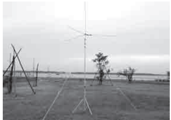
写真 5-4 マスト専用の三脚を利用してアンテナを設置
